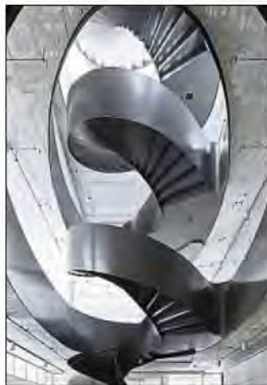
Die skulpturale Stahlwendeltreppe.
