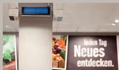
Die UV-C-Wandstrahler im Hamburger Edeka-Markt „Am Güterbahnhof“ sind eine unauffällige, aber effektive Lösung für virenfreie Luft. Die blauen Reflektoren fügen sich sogar ins blau-gelbe Corporate Design ein. Foto: Signify | www.signify.com
